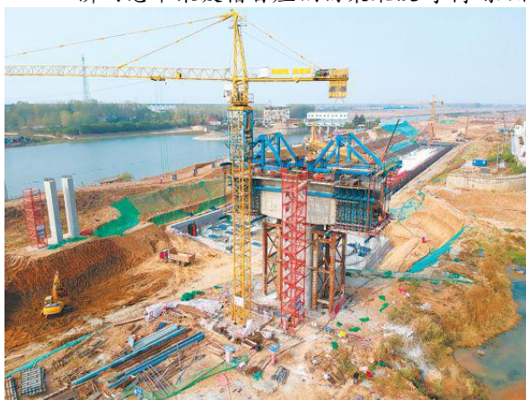
东淝闸施工现场 李博 余渊
