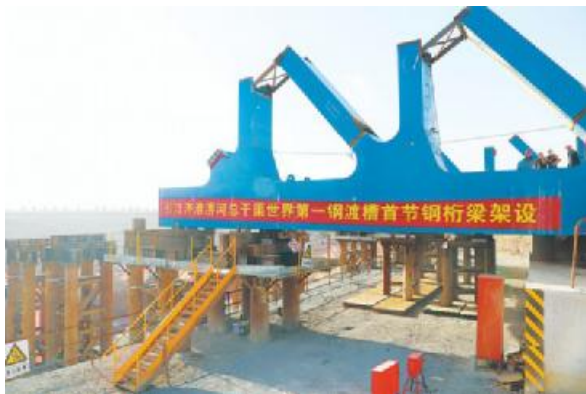
淠河总干渠渡槽首座钢桁梁架设 李博 余渊
